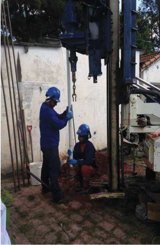
Fig 4: Após sondagem mecanizada, montagem do poço de monitoramento de água subterrânea.
