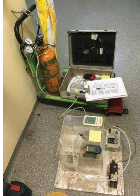
Fig 9: Materiais e equipamentos utilizados no teste de estanqueidade em todos os poços de vapor no contrapiso e solo.
