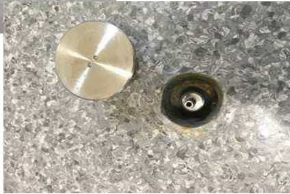
Fig 7: Poços de vapor no contrapiso, instalados na Edificação do Complexo Didático
